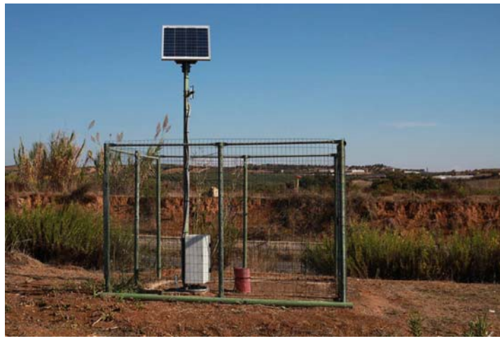
Stazione autonoma di misura di parametri fisici e chimici, alimentata tramite moduli fotovoltaici.
